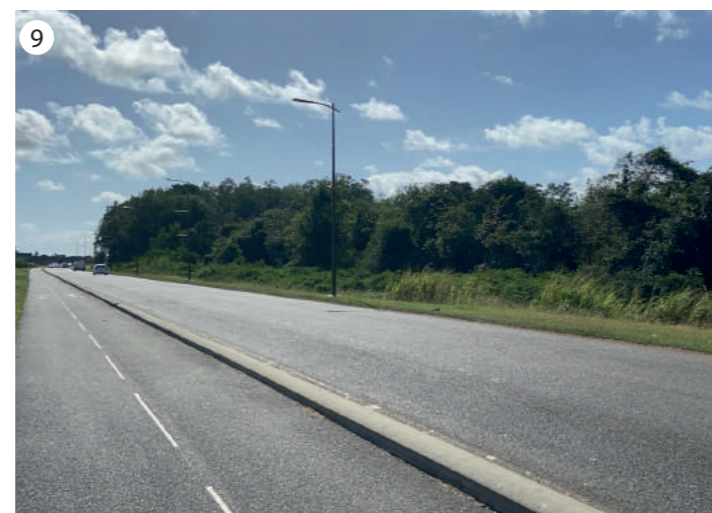
Récemment recalibrée, l'avenue de Pariacabo reçoit désormais une piste cyclable côté nord de la voie et un réseau d'éclairage remis à neuf.
